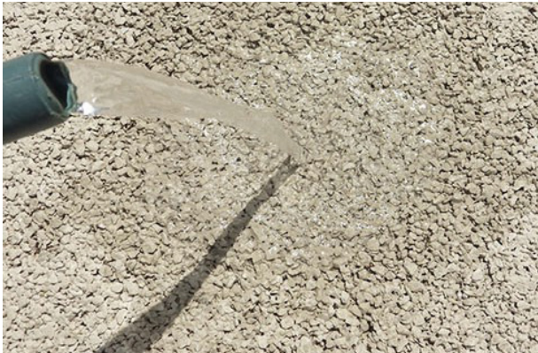
Die Wegebefestigung besteht überwiegend aus wasserdurchlässigem Asphalt und halbhartem Belägen die sich wunderbar in die Umgebung einfügen.
