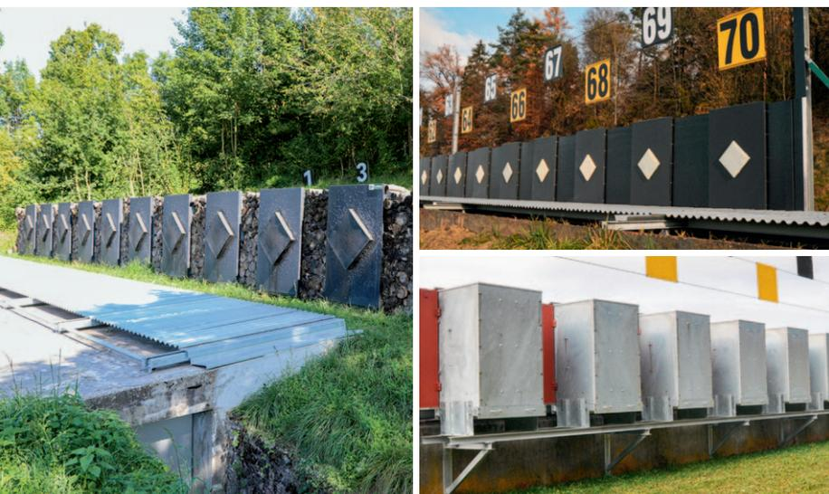
Künstliches Kugelfangsystem der Schiessanlage Berikon
