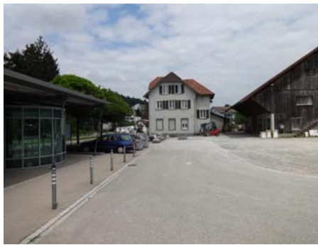
Parz. 233, Südwestansicht ehem. Rest. Bahnhof mit Zufahrt
