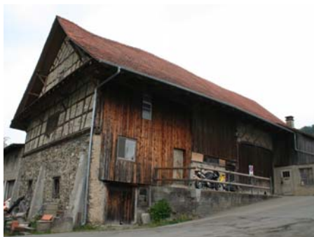
Parz. 1329, Westansicht des Werkhofgebäudes
