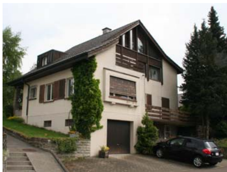
Parz. 1331, Nordansicht der Wohnbaute
