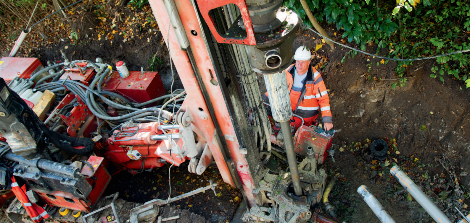
Erdsondenbohrung bis zu einer Tiefe von 290 Metern in der Schulanlage Dorf
